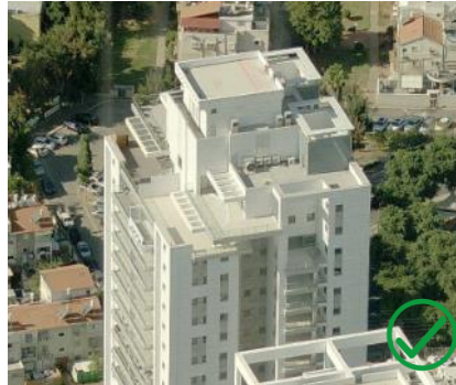
ריצוף בהיר, מסתור לתשתיות וקומה העליונה בנסיגה
